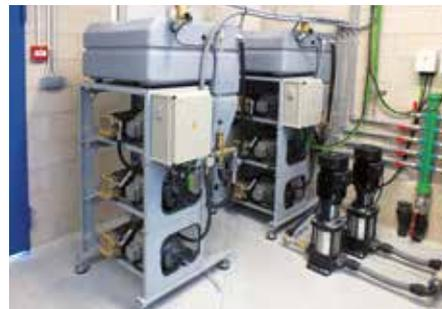
Disponemos de racks de electrobombas para el lavado a alta presión a **70 bar y 84-126 L/min**, con una potencia total de 11 o 16,5 kW, compuestos respectivamente por 2 o 3 electrobombas de 70 bar a una potencia de 5,5 kW. Incluyen un depósito de agua de **200 L** en posición elevada para alimentar correctamente las electrobombas y una válvula by-pass con regulador de presión. Su filtro de entrada de 100 micras protege las electrobombas y evita la obturación de las boquillas.
